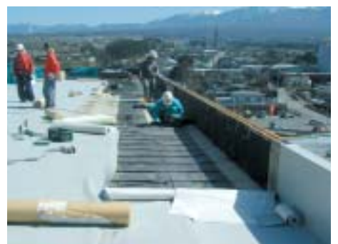
改修工事が進められる庁舎屋根
