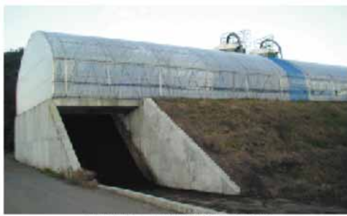
整備された堆肥利用施設（乙事）
