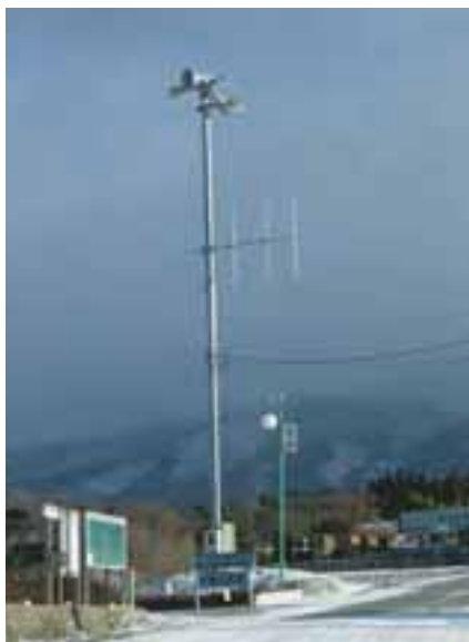
北杜市小淵沢町内に設置されている同報無線
