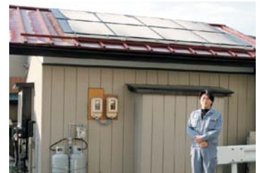
本社はもちろん、別棟には少ない日射量でも発電する「カネカ」のパネルを載せています。
